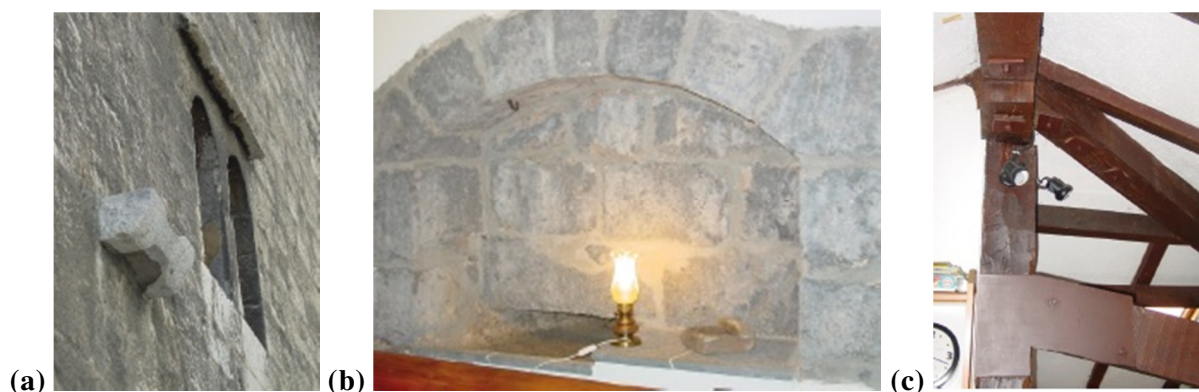
6. irudia.(a) Barruko hutsunea fatxada horman, (b) kanpoko isurketa harria, (c) egitura-errefortzua
